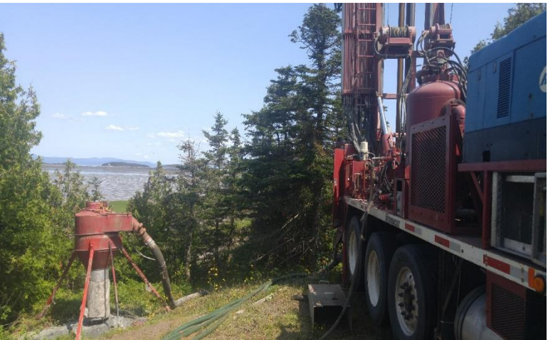
Figure 12- Forage du puits F-01 à Kamouraska avec une foreuse conventionnelle de type rotopercussion par la compagnie Puitbec
